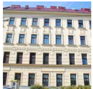
Sechshäuser Straße 82-84, 1150 Vienna
