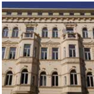
Sechshäuser Straße 34, 1150 Vienna
