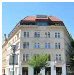
Hütteldorfer Straße 155, 1140 Wien
