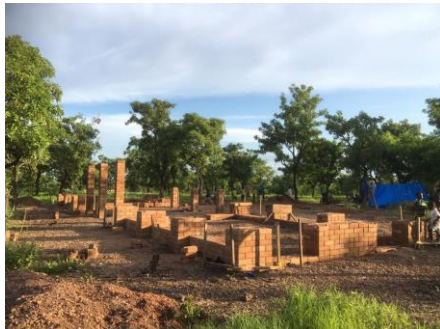
Foto 2: Fundament der neuen Cafeteria. Hier entsteht das Herzstück des Schulcampus.
